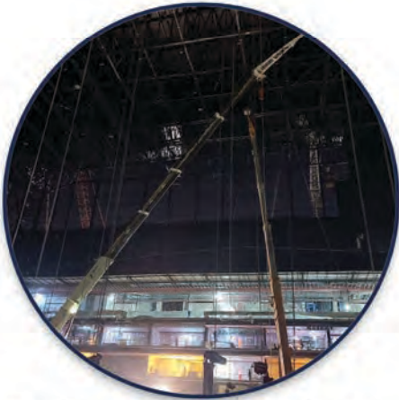
تنفيذ أعمال المنشآت المعدنية
